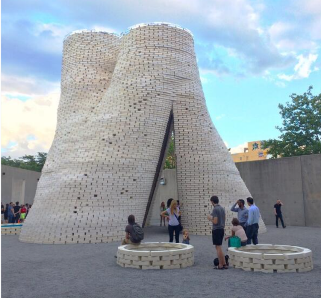
Şekil 4.25 : Mantar tabanlı malzeme ile inşa edilen “Hy-Fi” enstalasyonu (Url-34).
